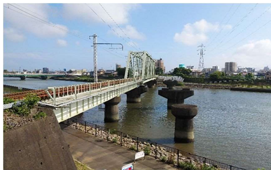
図 中川放水路橋梁
