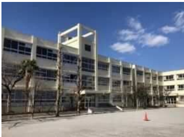
旧小谷野小学校 校舎
