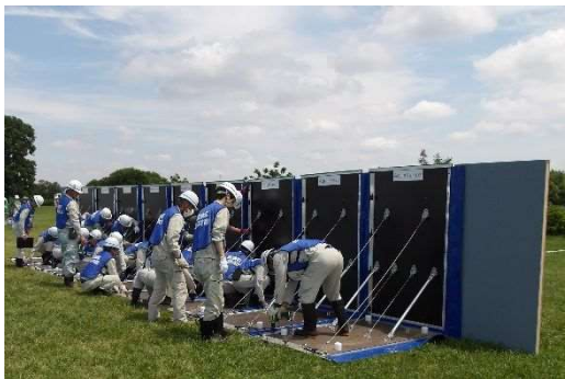
止水板設置状況
