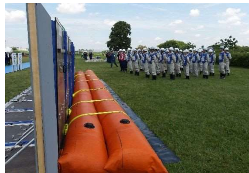
大型水のう設置状況
