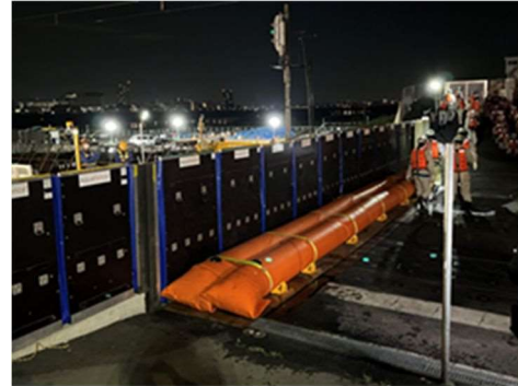
止水板・大型水のう設置完了
